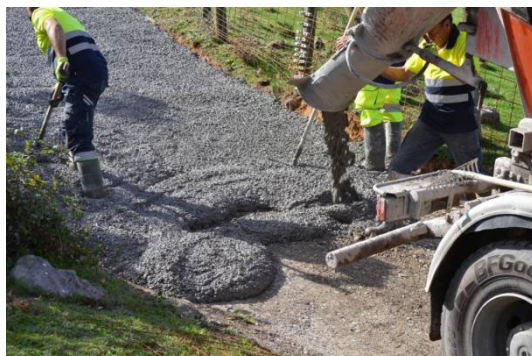
Hormigonado del recinto de Valle de Villaverde y de la pista de acceso a Cerdigo.
