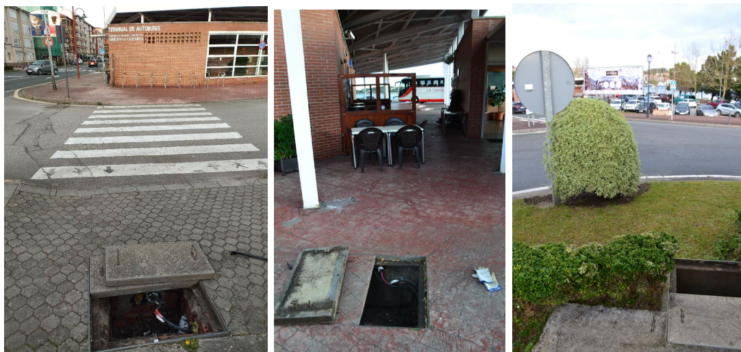
Detalle seguimiento obra San Vicente de la Barquera
